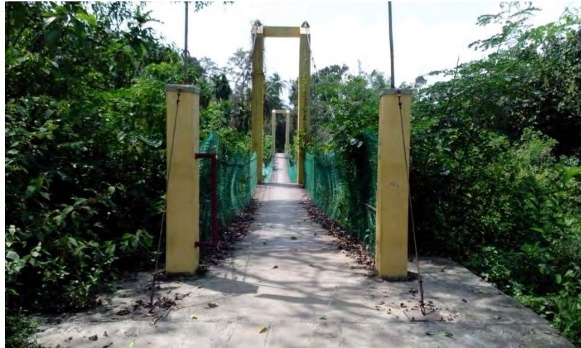
Foto 2.2: Jambatan Baharu Kampung Keledang
