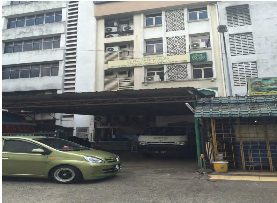
Gambar 4.3: Lokasi KMA1M (Bangunan Jam'iyah)
