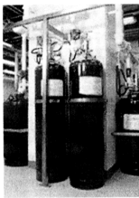
FM200 Cylinders Source : iadvantage
