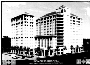
Gambar 2 : Kompleks Hospital Islam di Jalan Tun Razak ( masih dalam pembinaan )
