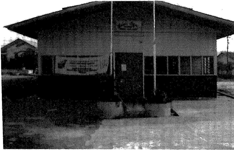
Community Hall of Kampung Sg. Kayu Ara
