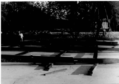
Gambar 2: Penyusunan tiang-tiang di tapak sebelum bangunan itu dibangunkan
