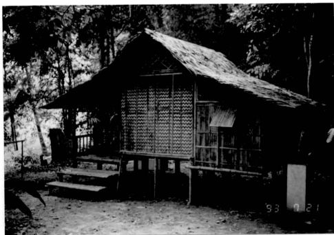
Gambar 28: Dinding daripada buluh - sejenis kelarai dan buluh cincang
