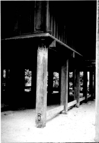
Gambar 25: Pemasangan alas, tiang, belira, rasuk, dinding dan bendul
