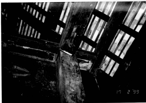
Gambar 1: Pemasangan kain berwarna di bahagian atas tiang
