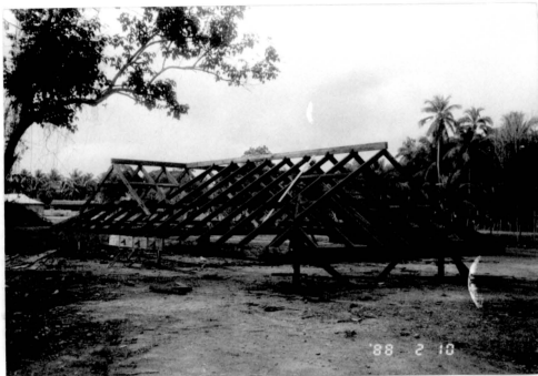
Gambar 3: Struktur dan komponen bumbung dipasang di bawah terlebih dahulu sebelum dibawa ke atas
