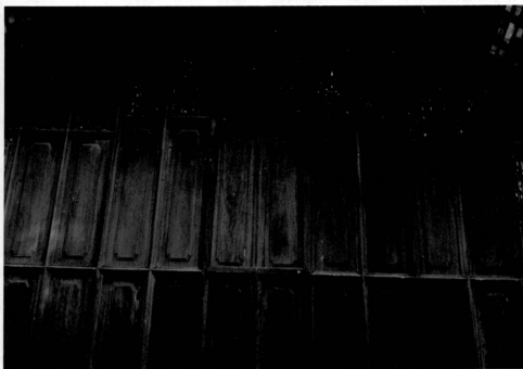
Gambar 32: Dinding daripada kayu - Jenis janda berhias atau kembung
