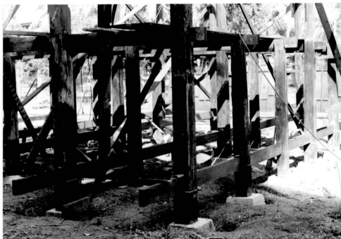
Gambar 24: Penyambungan alas, belira, tiang dan rasuk
