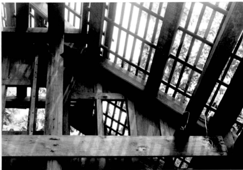
Gambar 37: Bentuk penyambungan serambi dengan bumbung utama
