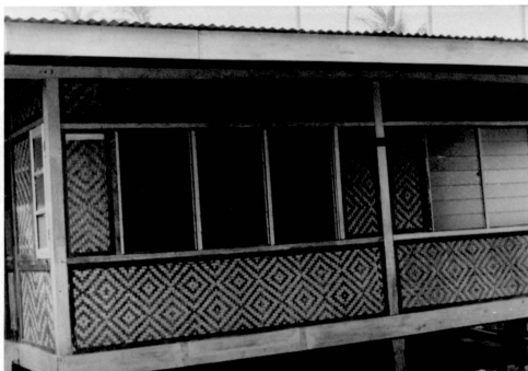
Gambar 29: Dinding buluh kelarai
