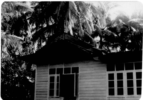
Gambar 30: Dinding daripada kayu - jenis susun sirih
