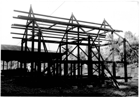
Gambar 5: Kerangka sebuah bangunan tradisional
