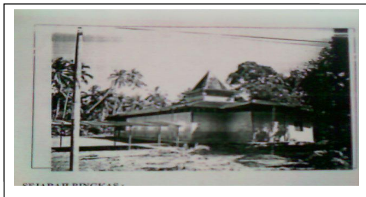
Rajah 3.4 Masjid lama yang digunakan dari tahun 1945 hingga 1961. (gambar fail Tn. Hj. Bohari Selamat)
