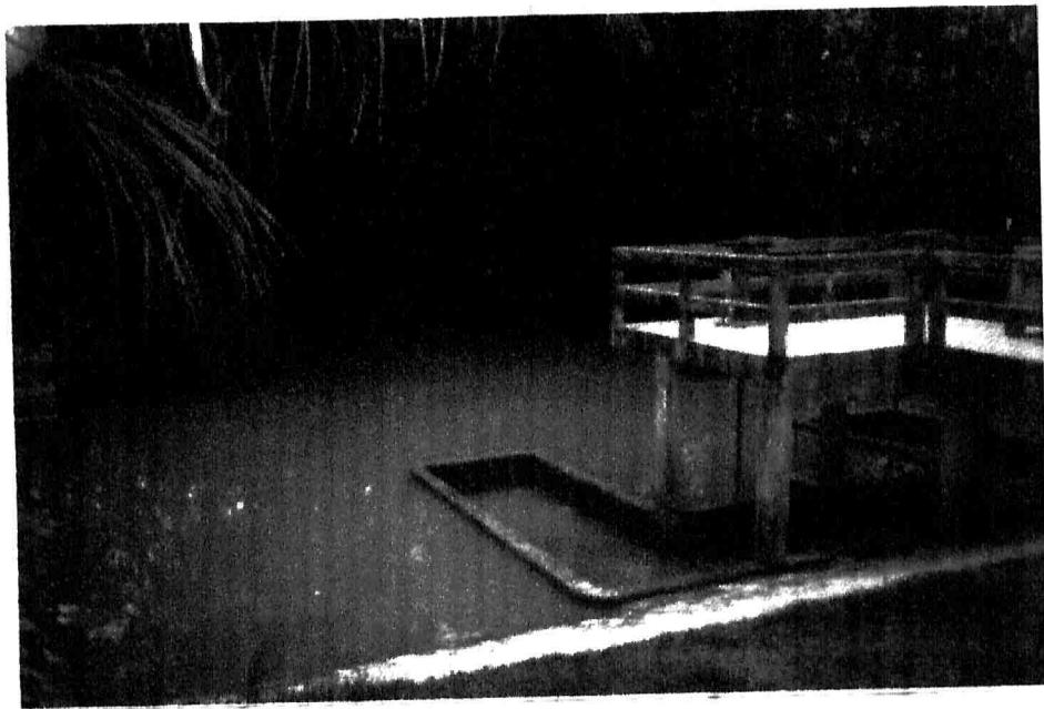
GAMBAR 4.1: *Chomprathan* yang dibuat untuk mengambil air lubuk bagi mengairi sawah di *Mubaan thi saam*.
