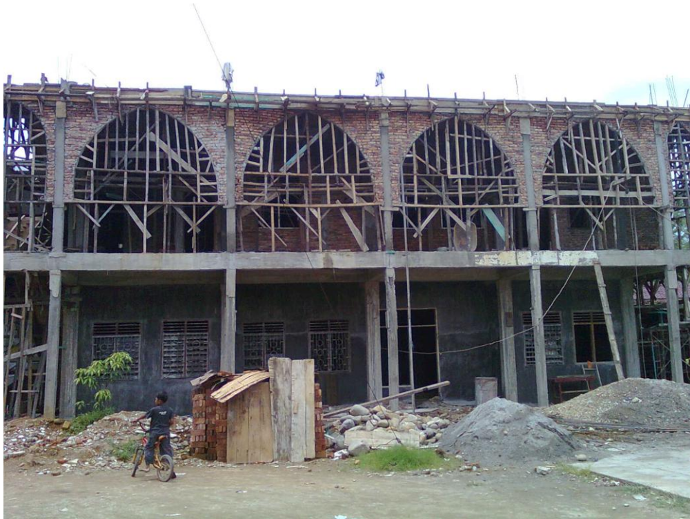
Penambahan Bangunan SMP, Proyek UNIVA
