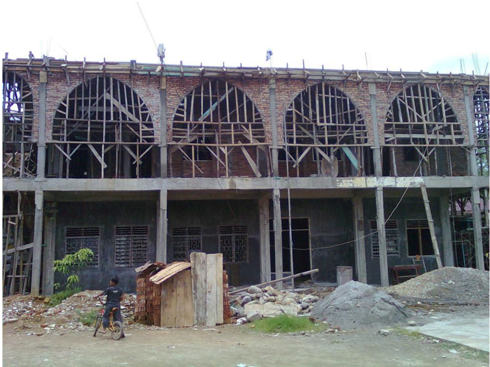
Penambahan Bangunan SMP, Proyek UNIVA
