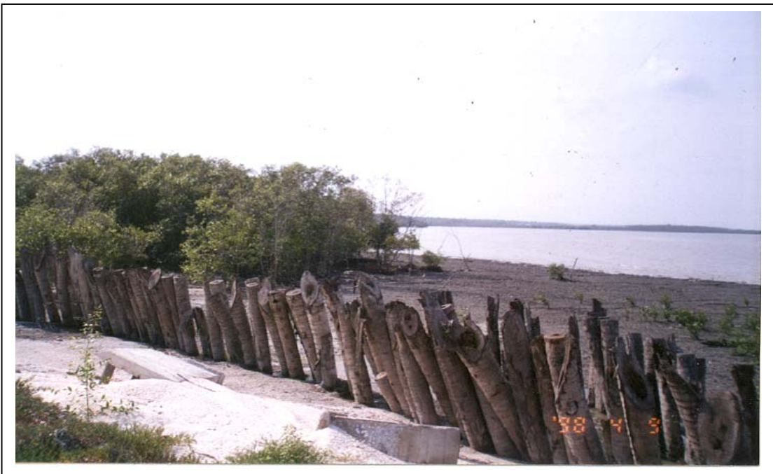
Fotograf 6.14 Kawasan pantai telah terhakis dan benteng batang kelapa dibina untuk melindungi kolam
