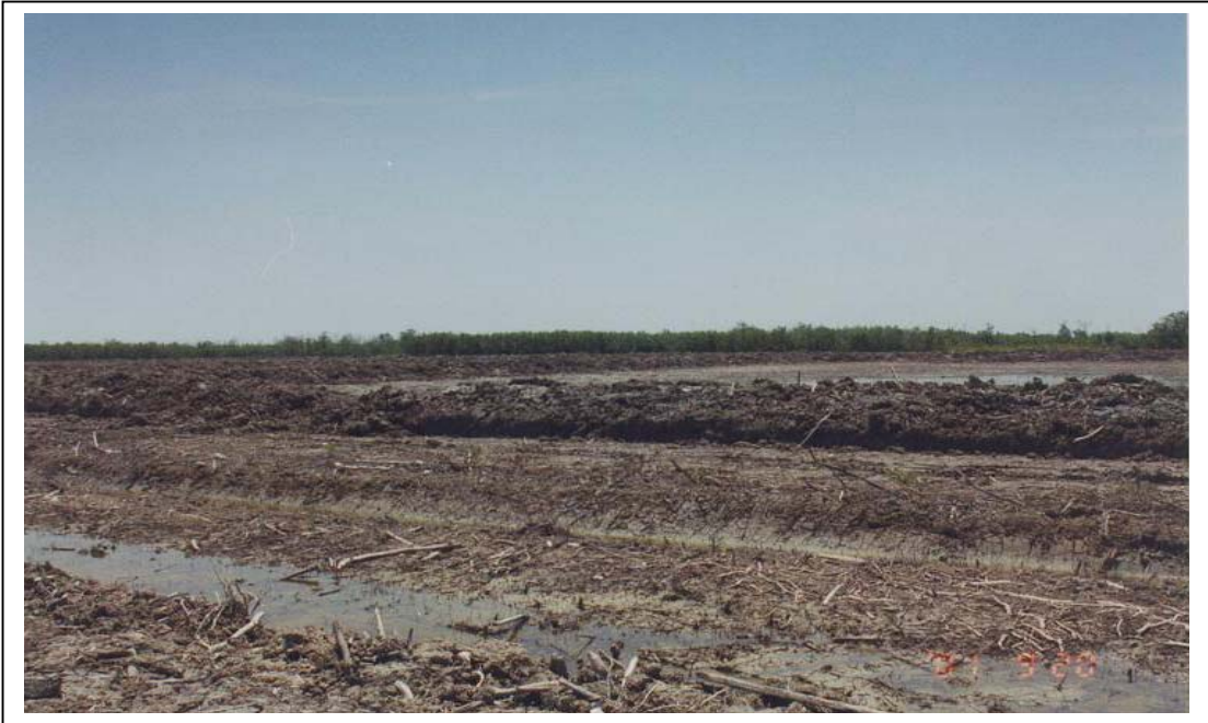
FOTOGRAF 6.5 Proses pembinaan kolam akuakultur sedang dijalankan
