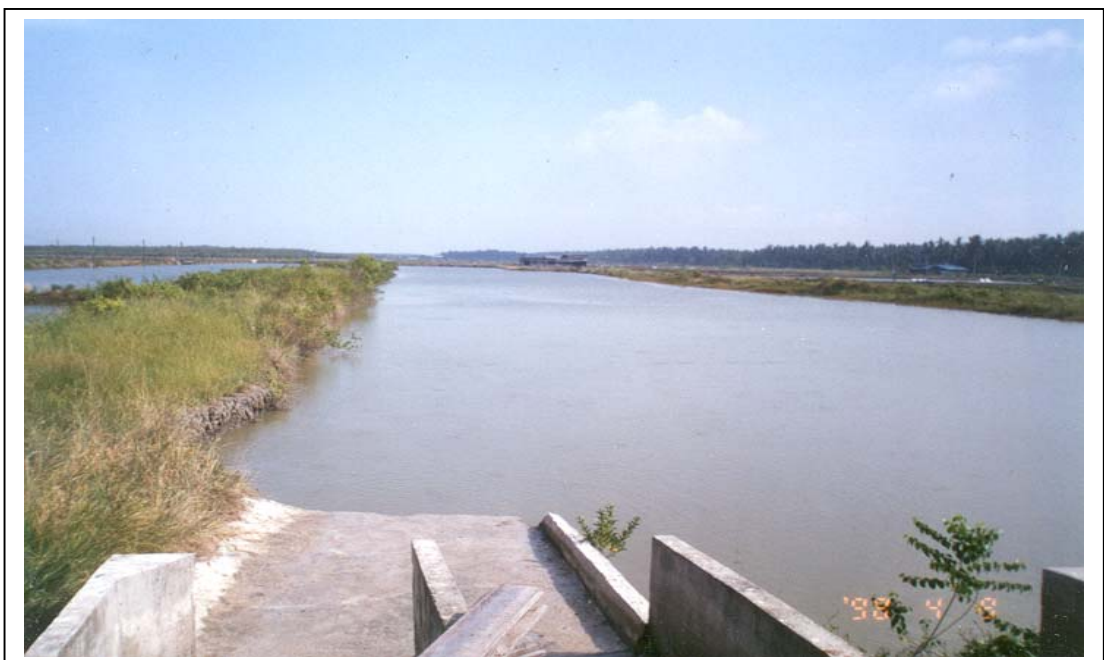
FOTOGRAF 6.12 Air yang dipam masuk dimendapkan di kolam takungan
