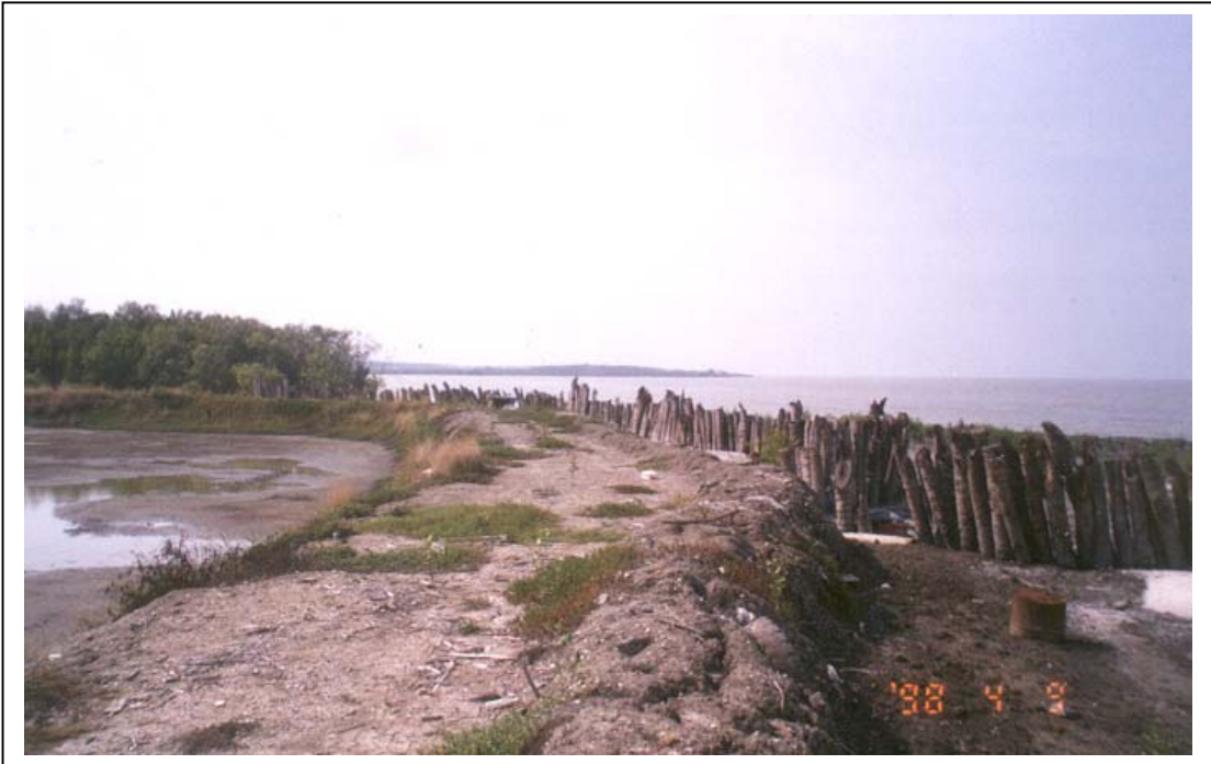
Fotograf 6.13 Kawasan pantai telah terhakis dan benteng batang kelapa dibina untuk melindungi kolam
