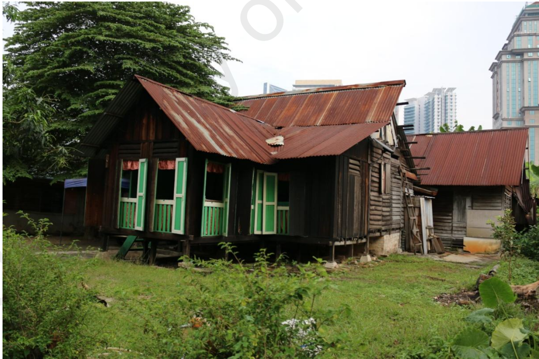
Gambar 4.18: Rumah usang yang masih terdapat di Kampong Bharu (Sumber: Kajian lapangan pengkaji)
