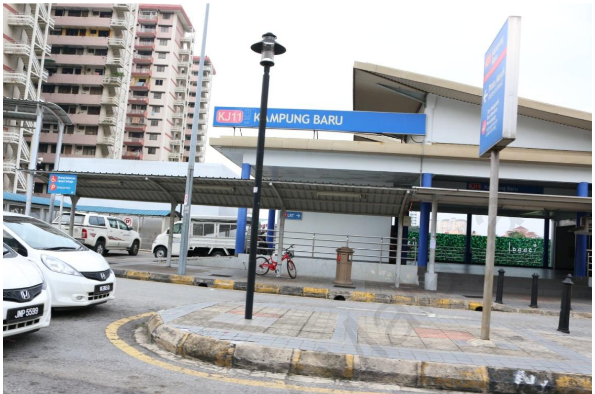
Gambar 4.1: LRT Kampong Bharu (Sumber: Kajian lapangan pengkaji)
