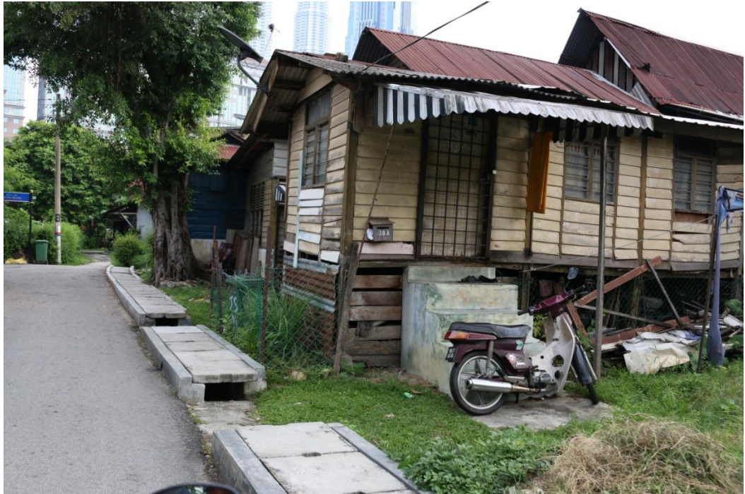
Gambar 4.17: Rumah usang yang masih terdapat di Kampong Bharu (Sumber: Kajian lapangan pengkaji)
