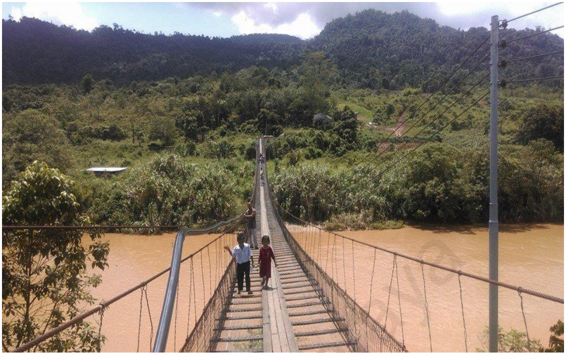
Gambar 13: Laluan utama ke Kampung Padang, Sepulut Pensiangan, dengan menggunakan jambatan gantung
