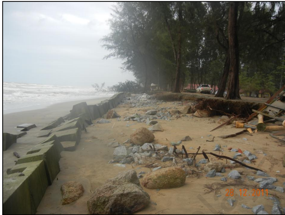
Rajah 5.35 (b): Benteng konkrit yang musnah di Pantai Irama, Bachok
