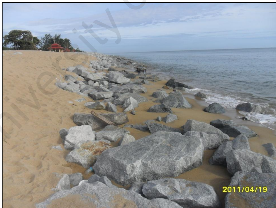
Rajah 5.18 (c): Benteng yang lebih awal dibina di Pantai Cahaya Bulan telah musnah kesan daripada tindakan ombak dan juga arus
