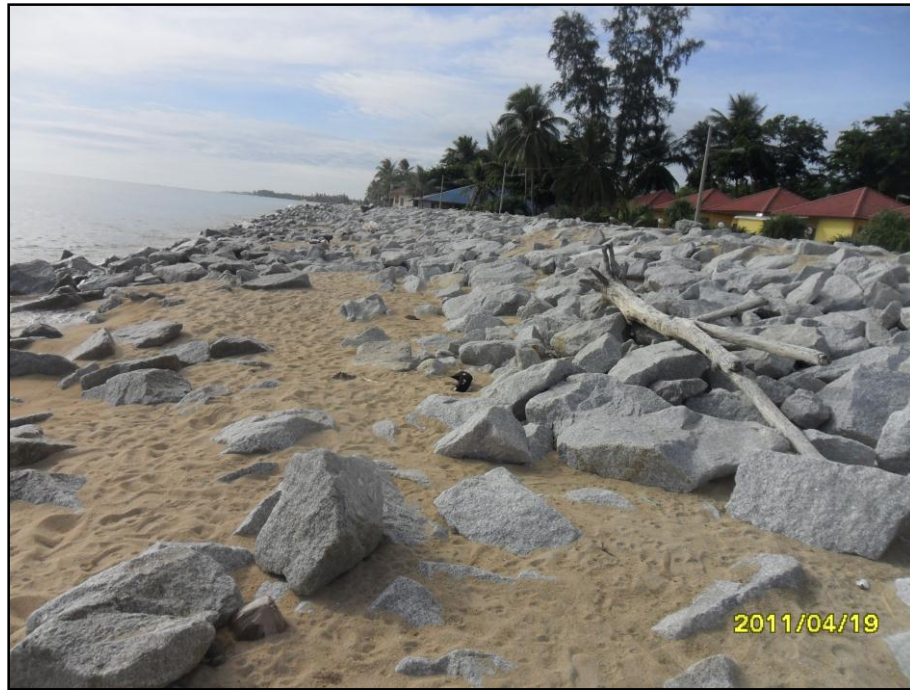
Rajah 5.35 (c): Benteng bongkah batuan yang musnah sedikit demi sedikit di Pantai Cahaya Bulan, Kota Bharu
