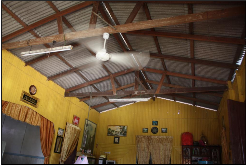
Rajah 5.30 (b): Bahagian bumbung yang tinggi turut berfungsi dalam menghasilkan pengudaraan yang baik
