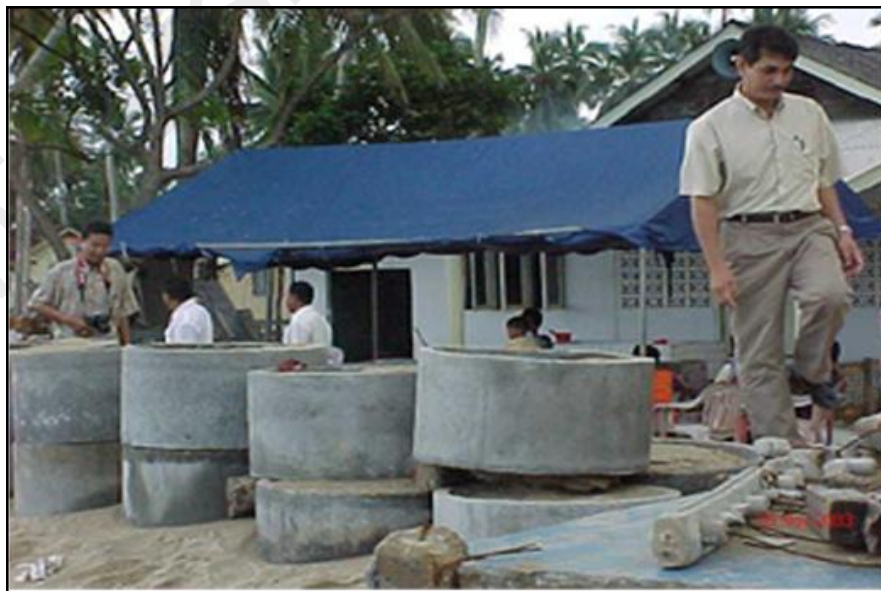
Rajah 5.34 (d): Adaptasi serta merta daripada simen konkrit yang lebih kukuh dan boleh bertahan untuk tempoh masa yang lebih panjang
